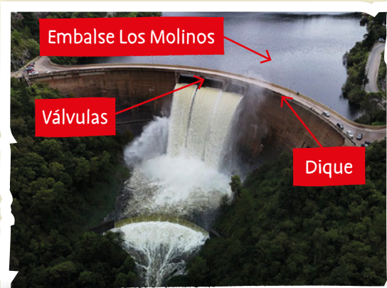
» Apertura de válvulas en el dique Los Molinos.
